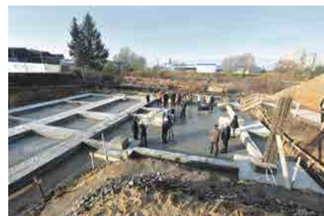
Plac budowy. Na razie fundamenty, w przyszłym roku nowoczesny budynek. Fot. Krzysztof Grabowski
