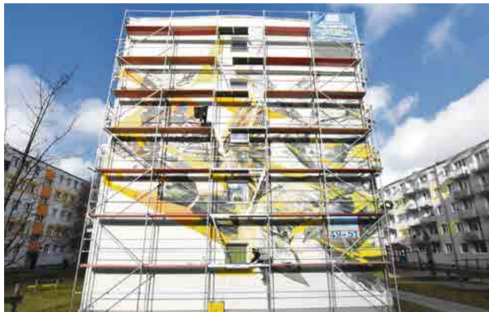
Ostatniego z ptasich murali nie możemy jeszcze podziwiać w pełnej krasie, nadal skrywają go rusztowania
