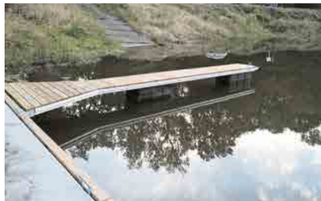
Wszystkie pomosty są umieszczone na pływakach i połączone ruchomymi elementami. Dzięki temu bez problemu dopływają się do poziomu wody.
