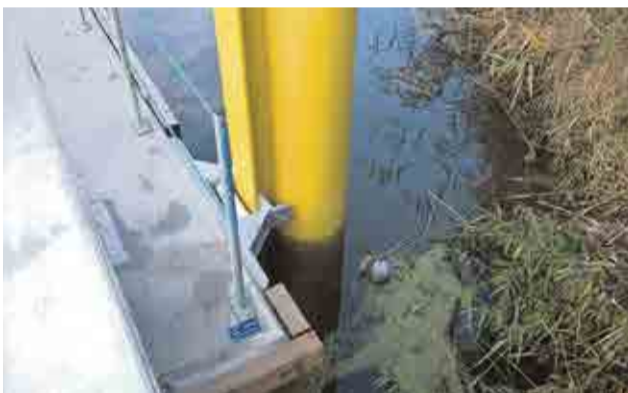
Stalowy słup wbity w dno rzeki, tzw. dalba, dzięki specjalnym rolkom umożliwia podnoszenie i opadanie przystani wraz z poziomem wody w rzece.
