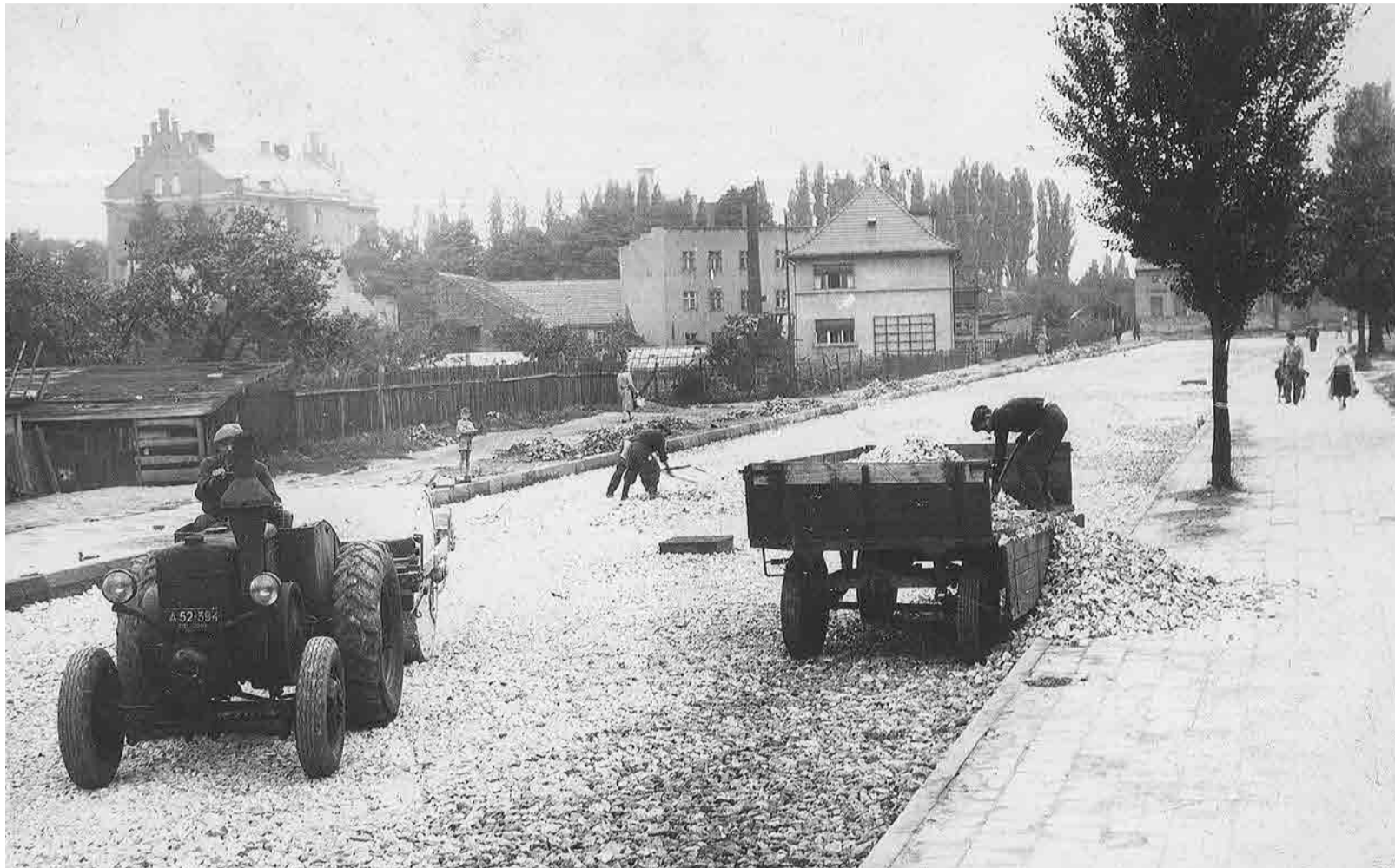
Budowa ulicy Topolowej. Z widocznych na zdjęciu domów przetrwał jedynie budynek ODN-u przy ul. Chopina. Na zdjęciu z tyłu po lewej stronie.
