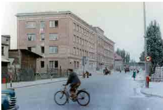
Budowa tzw. budynku spółdzielczości lekarskiej - widok od al. Wojska Polskiego
