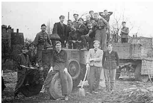
Młodzież szkolna pracująca przy budowie ulicy - okolice skrzyżowania z ul. Kupiecką
