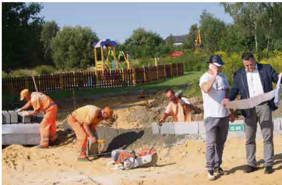
Wójt Robert Sidoruk nie jest zadowolony z tempa prac na budowie Fot. Urząd Gminy Zabór
