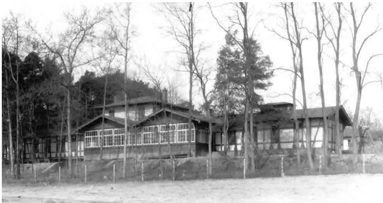
Lata 20. Tak wyglądało przedszkole (wtedy dom dziecka) po rozbudowie.
