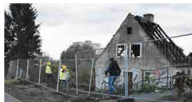
Na razie na działce trwają prace porządkowe
