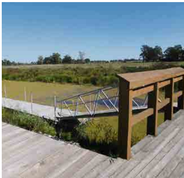
Pomost prawie gotowy, tylko wody nie widać...
