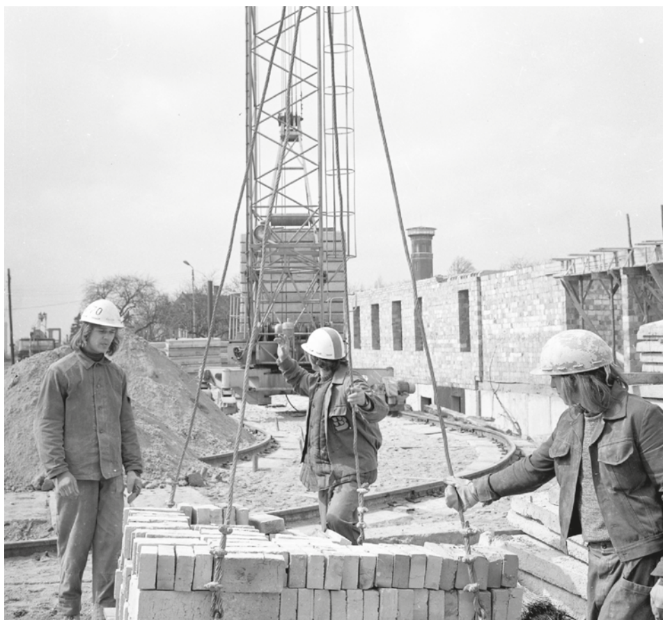
Prace przy budowie Domu rozpoczęły się w 1974 r.
