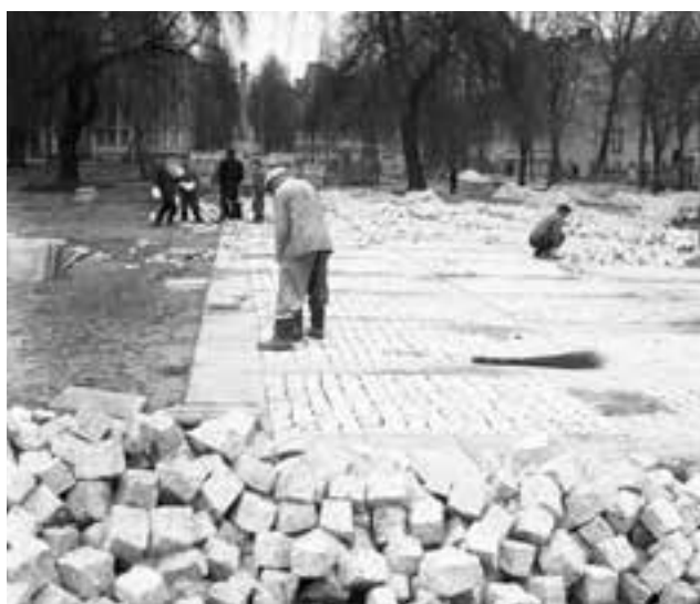
Roboty na placu rozpoczęto od układania bruku. Z tyłu stoi jeszcze stary pomnik
