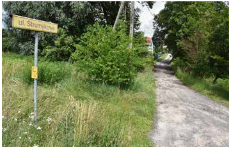
Dzięki dofinansowaniu z PROW przebudowana będzie ulica Strumykowa w Płotach, na której położony zostanie polbruk Fot. Krzysztof Grabowski
