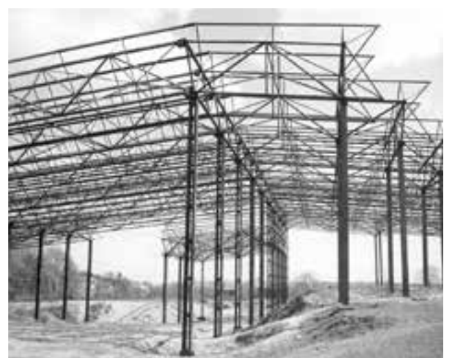
Konstrukcja palmiarni - 1982 r. Później teren zarósł, ćwierć wieku później stalowe kratownice wywieziono na złom.
