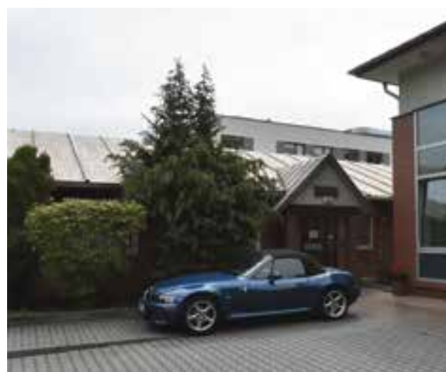
Wejście do hospicjum. Nowoczesny budynek powstał w 2007 r. Stara, po lewej stronie, zostanie zburzona.
