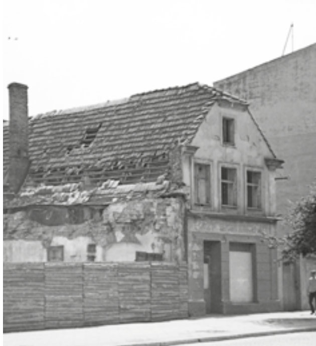
Wyburzenia na ul. Kupieckiej - również takie domy stały w centrum miasta
