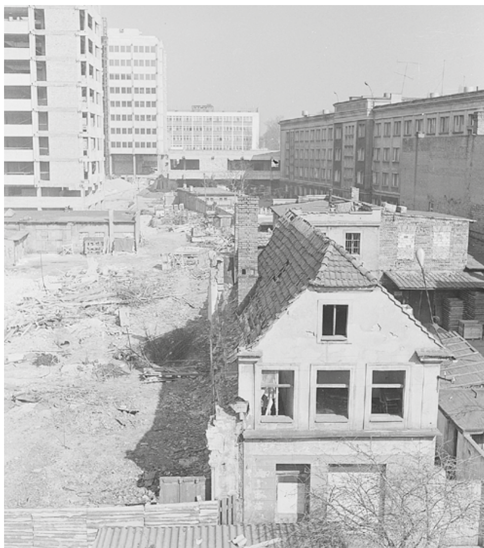
1973 r. Trwa budowa centrum biurowo-usługowego. Widok od strony ul. Kupieckiej, gdzie są wyburzane ostatnie stare domy. Fot. Czesław Łuniewicz - dziedzictwo/Archiwum Państwowe
