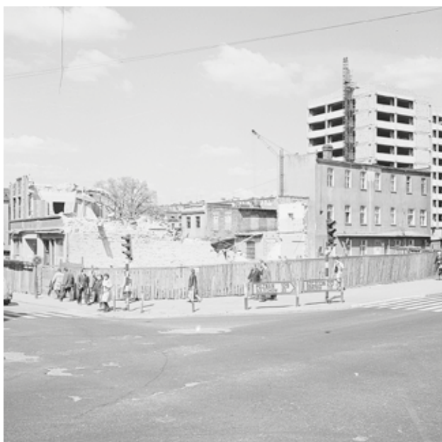
1973 r. Trwa wyburzanie domów z rogu ul. Kupieckiej i Bohaterów Westerplatte. Wówczas jeździło się tędy w kierunku Wrocławia i Szczecina. Fot. Czesław Łuniewicz
