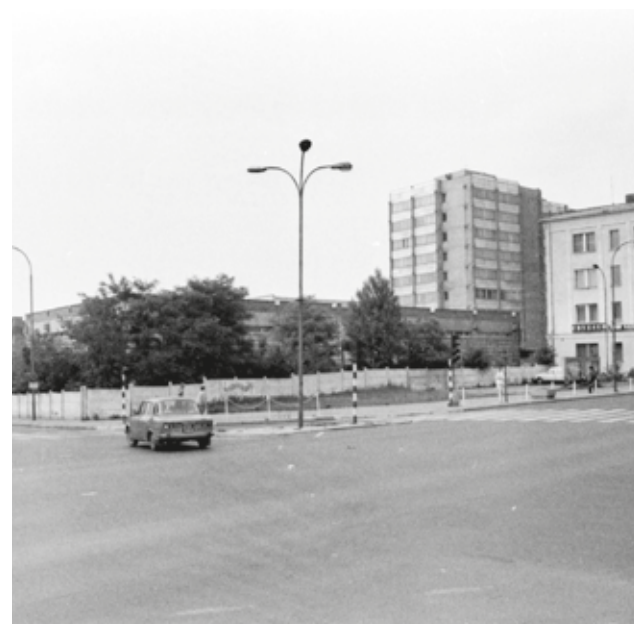
To samo skrzyżowanie – ok. 10 lat później. Rozgrzebana budowa sklepu Hermes czeka na dokończenie inwestycji. Fot. Zbigniew Rajche
