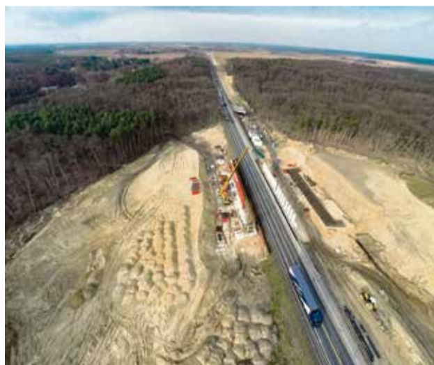
Budowa przejścia dla zwierząt na odcinku Sulechów - Cigacice
