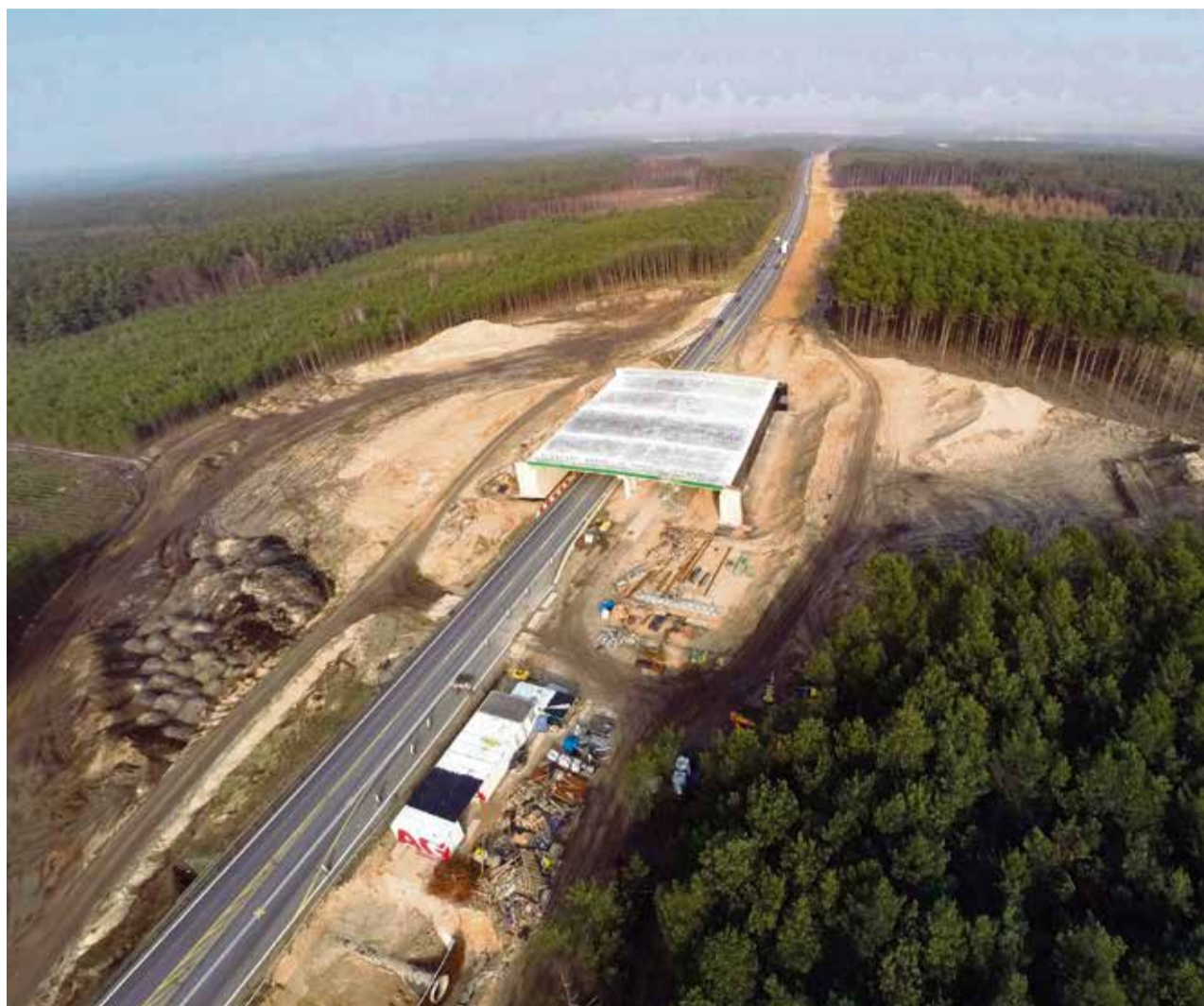
Tak wygląda budowa przejścia dla zwierząt na odcinku Cigacice - Zawada Fot. Archiwum zielonogórskiego oddziału GDDKiA
