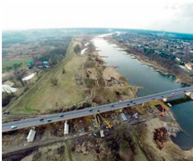
Budowa nowego mostu na Odrze
