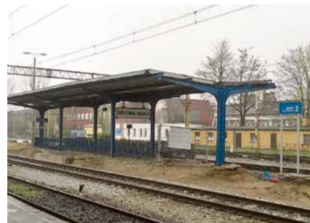
Wiata na peronie nr 2 stała w tym miejscu przez 111 lat, wkrótce zostanie zdemontowana Fot. Tomasz Czyżniewski
