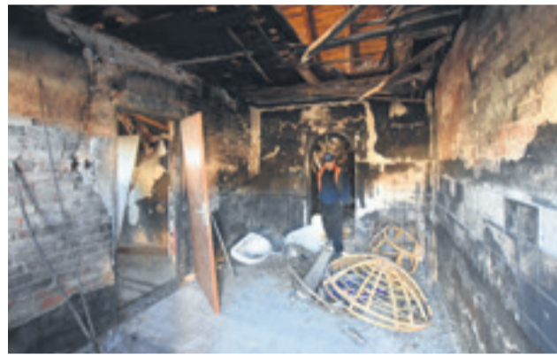
Wnętrze budynku jest w opłakanym stanie
