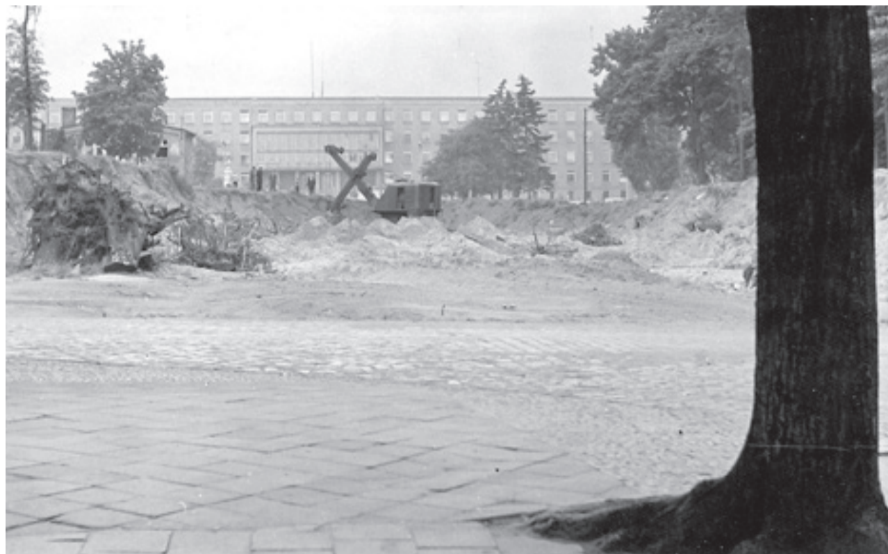
Czerwiec 1966 r. Trwają prace przy przekopywaniu się przez cmentarz.
