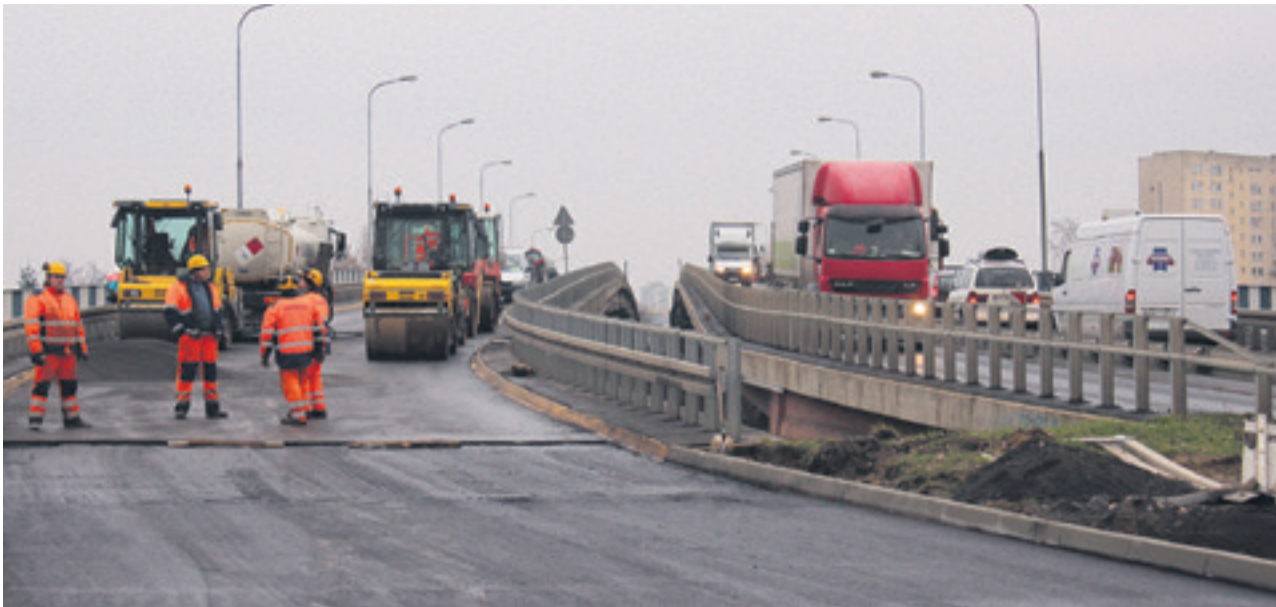
Newralgiczny punkt - zjazd z wiaduktu przy skrzyżowaniu al. Zjednoczenia z Energetyków. We wtorek, wylewano tutaj ostatnią warstwę asfaltu.
