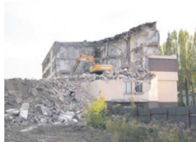
Październik 2011 r. Trwa rozbiórka hotelu. To ostateczny koniec historii Polanu.
