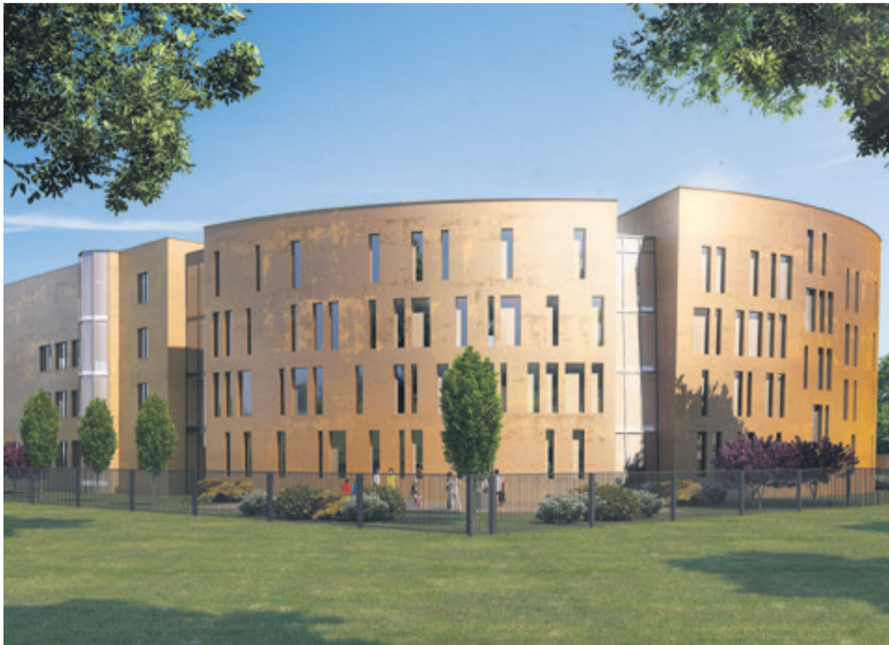
Budowa szkoły muzycznej kosztować będzie ok. 22 mln zł brutto
