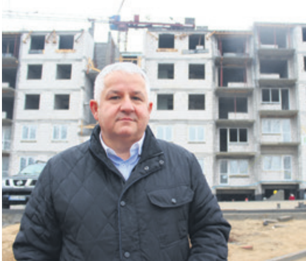
Os. Śląskie to najnowszy plac budowy KTBS
