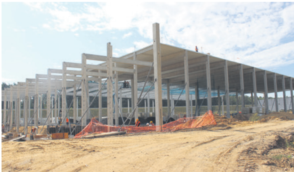
Nowobudowane centrum logistyczne ma być gotowe w marcu przyszłego roku
