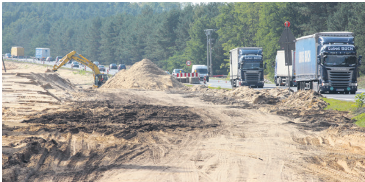
Okolice Zawady, trwają prace przy niwelacji terenu pod drugą nitkę trasy ekspresowej S3
