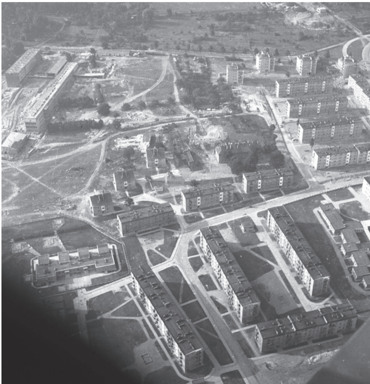
Trwa budowa budynków WSI nz przy ul. Podgórnej. Zdjęcie lotnicze z początków lat 60.
