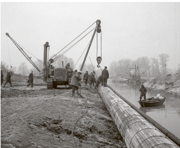
Rok 1974. Przygotowania do ułożenia rurociągu na dnie Odry
