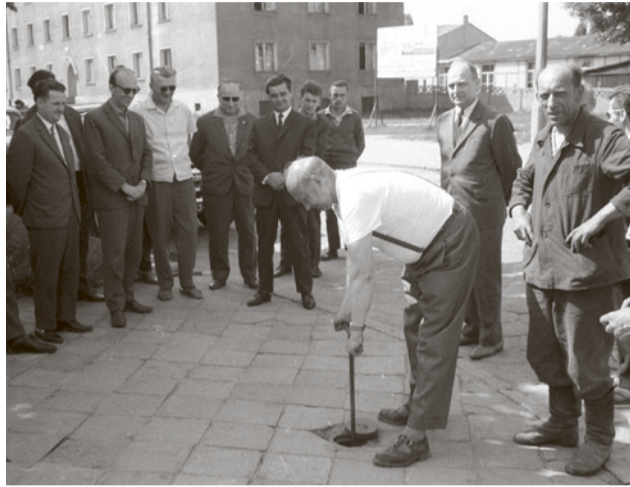
Lata 60. Ul. Wyspiańskiego, uruchomienie wodociągu dostarczającego wodę na os. Wazów.
