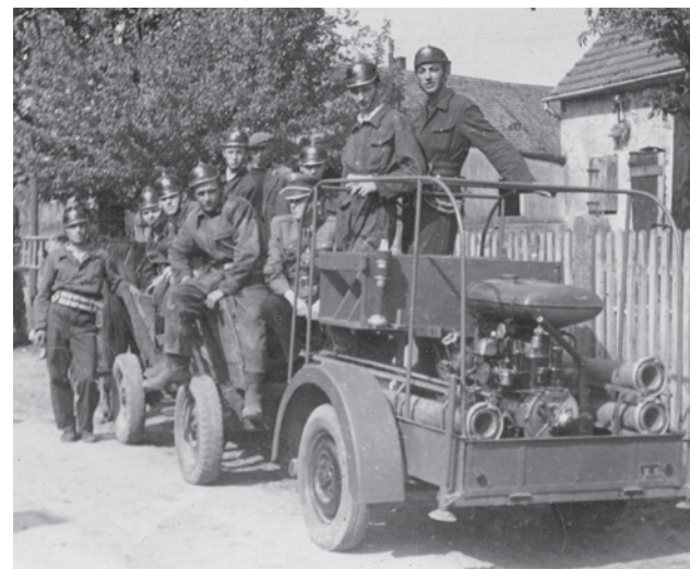
Zestaw konno-zmotoryzowany. Koń ciągnie wóz ze strażakami, do którego podpięta jest przyczepa z motopompą
