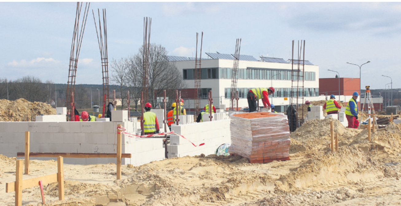
Mimo kaprysów aury, dziennik budowy nie odnotował opóźnień. Do końca tygodnia zostaną położone wszystkie fundamenty Fot. Krzysztof Grabowski
