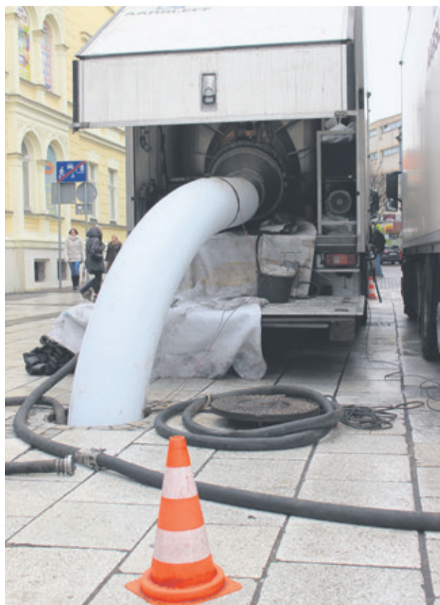
Pod ziemię wprowadzany jest specjalny rękaw, który pod wpływem pary twardnieje i uszczelnia rury kanalizacyjne Fot. Krzysztof Grabowski
