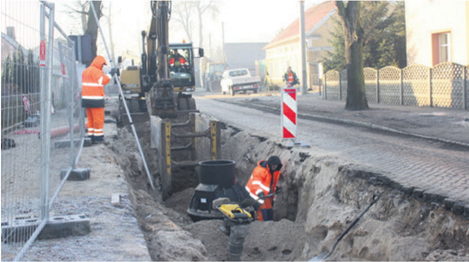
Zawada. Grudzień. Prace ziemne na głównej ulicy Zielonogórskiej Fot. Krzysztof Grabowski
