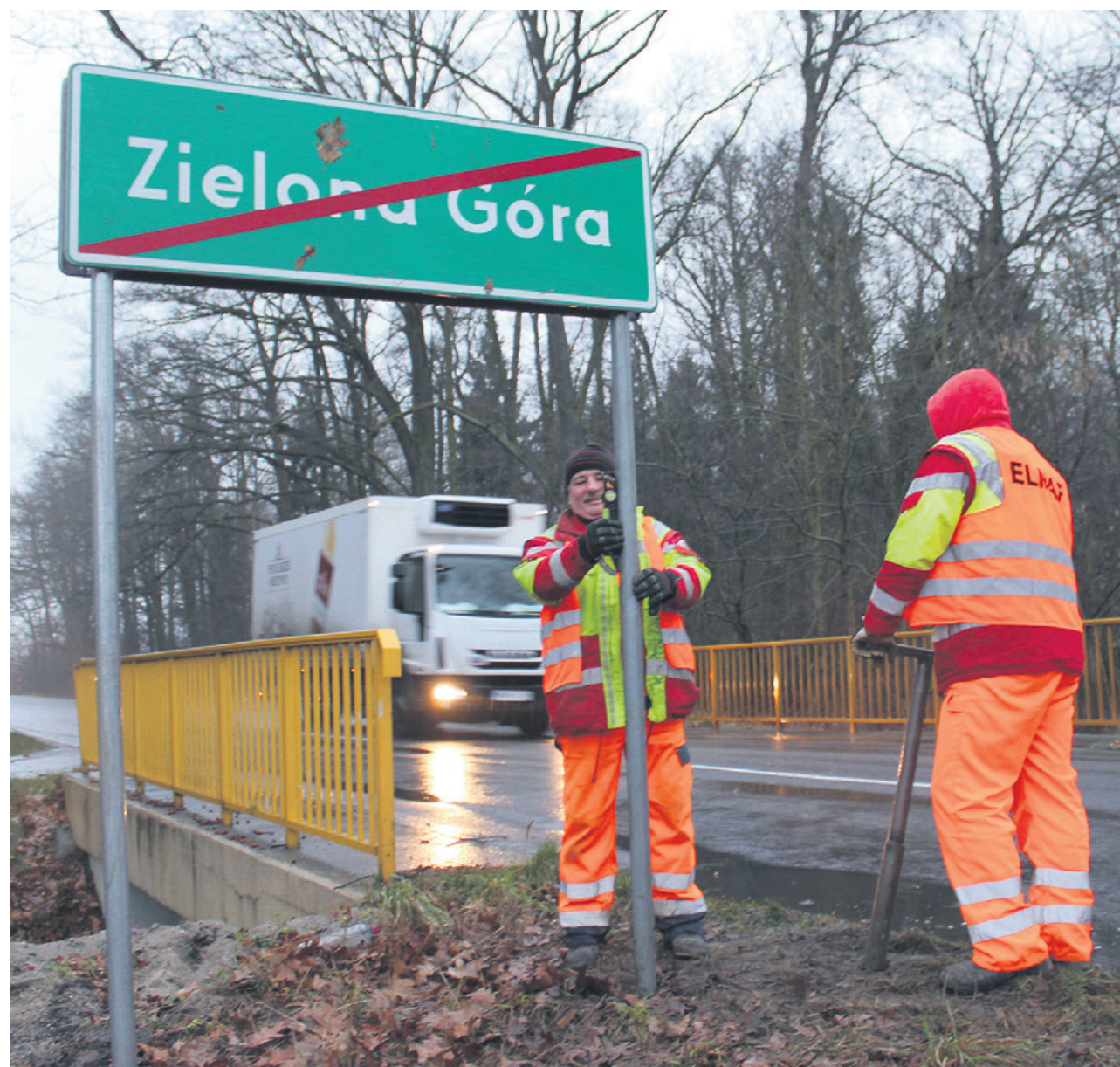
W poniedziałek, ekipa drogowa pracowała na terenie sołectwa Przylep. Dużą zieloną tablicę montowała kilkaset metrów za przejazdem kolejowym, w kierunku na Ploty
