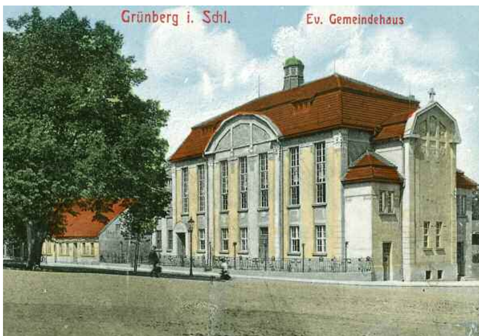
Budynek filharmonii - widok przedwojenny
