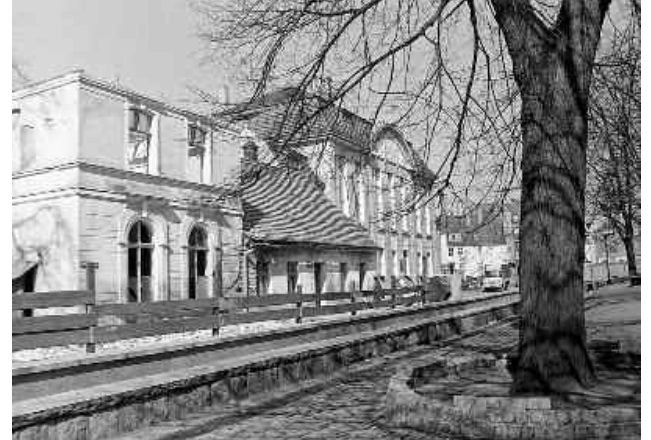
Ekipy budowlane błyskawicznie rozprawiły się ze starymi budynkami Fot. Zbigniew Rajche
