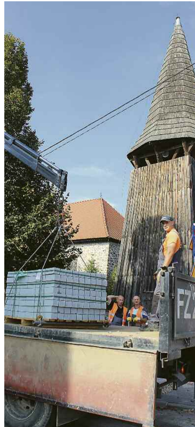
ZBD „Grzesiewicz” z Zielonej Góry remontuje ul. Św. Mikołaja. Budowlanom najbardziej dokucza brak miejsca. Ulica jest wąska, szczególnie zabudowana. Nie ma miejsca na podręczny magazyn. Na bieżąco trzeba dowozić wszystkie materiały.
