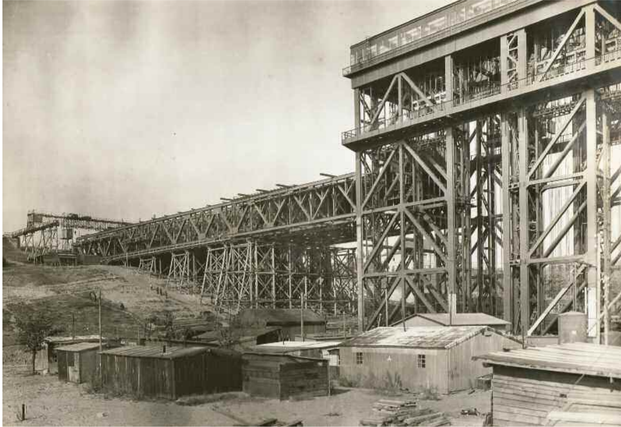
Budowa podnośni (październik 1932 r.). Środkowa część to most kanałowy łączący podnośnię z kanałem lądowym
