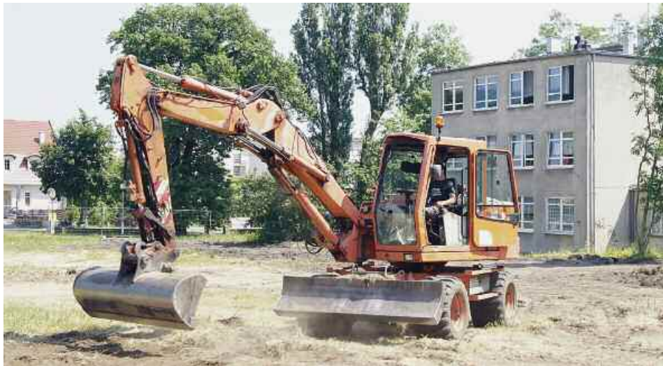
We wrześniu, przy ul. Botanicznej będzie nowiutkie boisko. Na razie uwijają się tu ekipy budowlanców. Kiedy odwiedziliśmy tydzień temu plac robót, zdzierali darń. Fot. Krzysztof Grabowski
