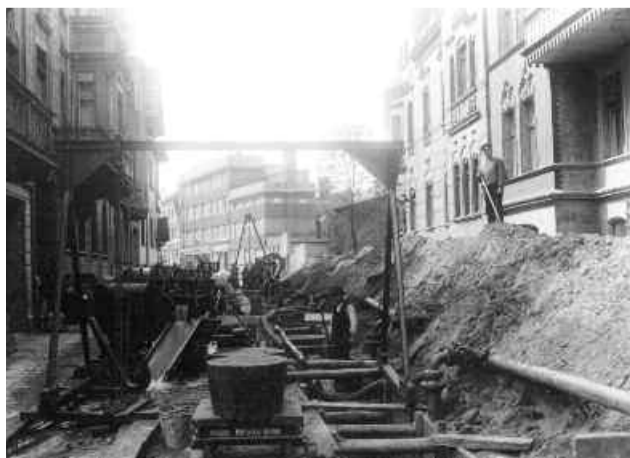
Wykoppy na ul. Reja
