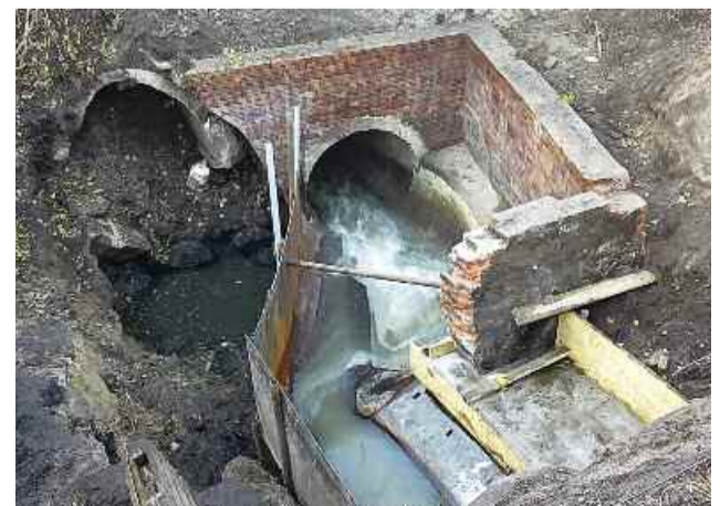
Przedwojenna komora kanalizacyjna przy ul. Węglowej
