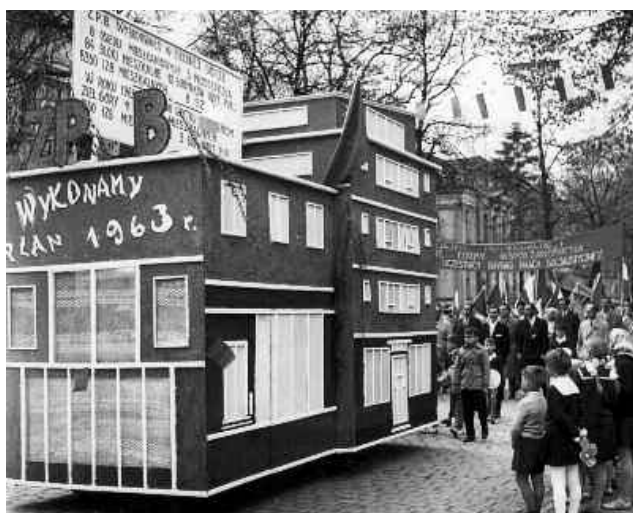
Rok 1963. Jest okazja, by pochwalić się osiągnięciami w budownictwie.
