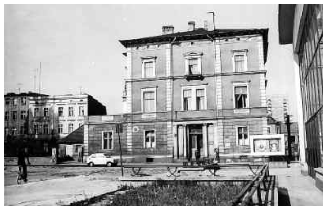
Zabytkowa willa Försterów, zburzona podczas budowy al. Konstytucji 3 Maja Fot. Bronisław Bugiel
