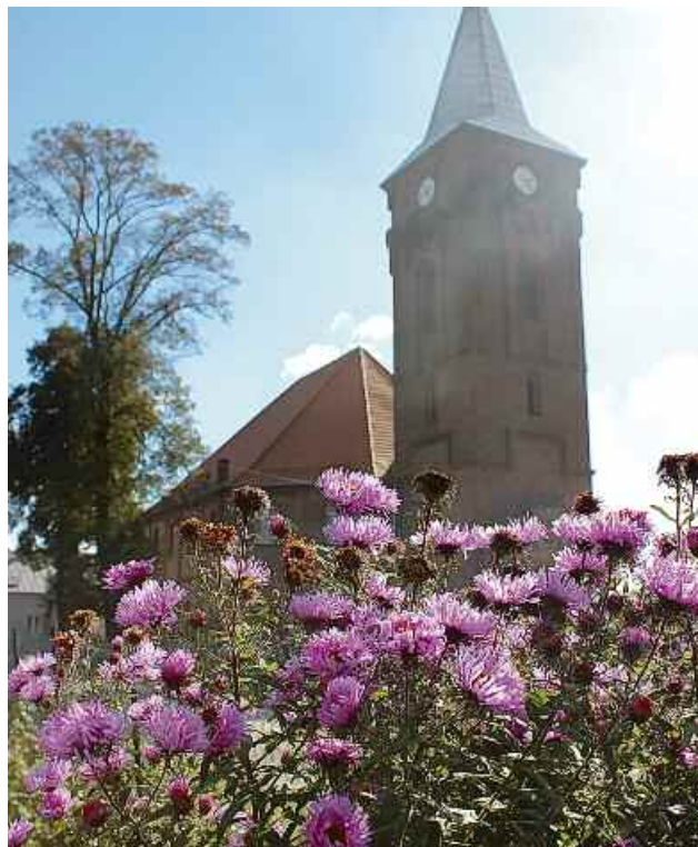
Zatonie postanowiło dopieścić swoje zabytki. W tym roku 20 tys. zł trafi na remont sklepienia kościoła pw. Matki Boskiej Częstochowskiej. Fot. Krzysztof Grabowski
