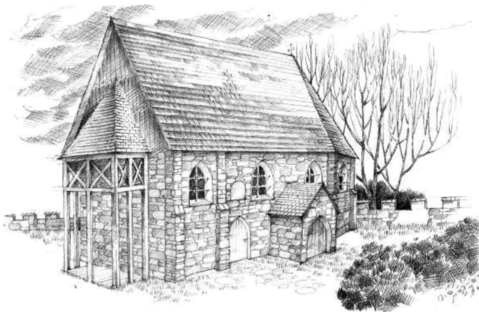
Rekonstrukcja kościoła pw. św. Jana wykonana współcześnie
