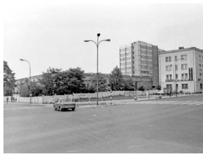
Budowa Hermesa ciągnęła się tak długo, że na placu budowy wyrosły drzewa. Lata 80.
