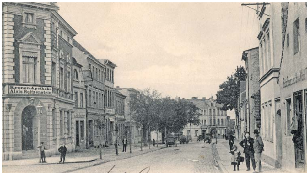
Przełom XIX i XX wieku. Obecne skrzyżowanie ul. Kupieckiej i Bohaterów Westerplatte, która powstanie pół wieku później, w miejscu domów po prawej stronie.
