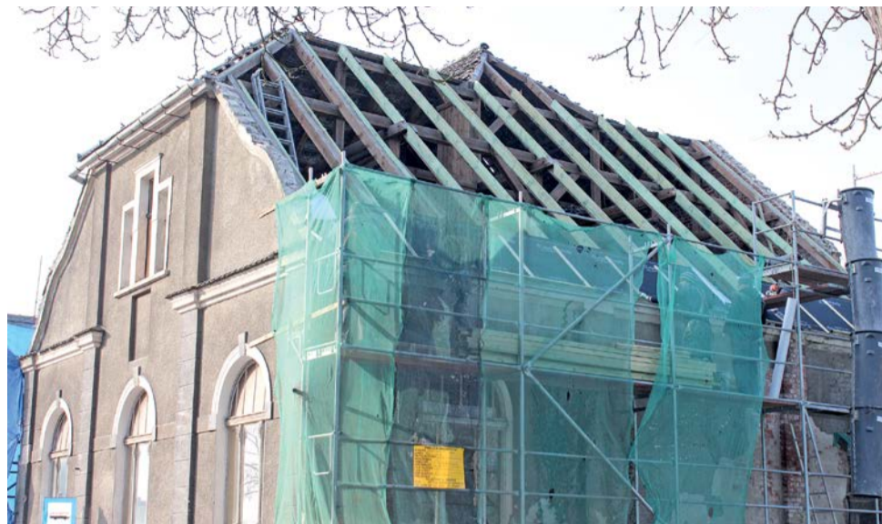
Ekipa m.in. wzmocni więźbę i przełoży dachówkę. Świetlica w Zatoniu będzie miała piękną „marsylkę”.
