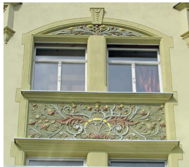
Ul. Reja 3. Blask odzyskała secesyjna kamienica, odnowiono piękne detale architektoniczne. Fot. Urząd Miasta Zielona Góra
