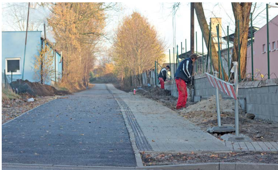
Firma Exalo Drilling z asfaltową ścieżką „dobiła” właśnie do ul. Kożuchowskiej
