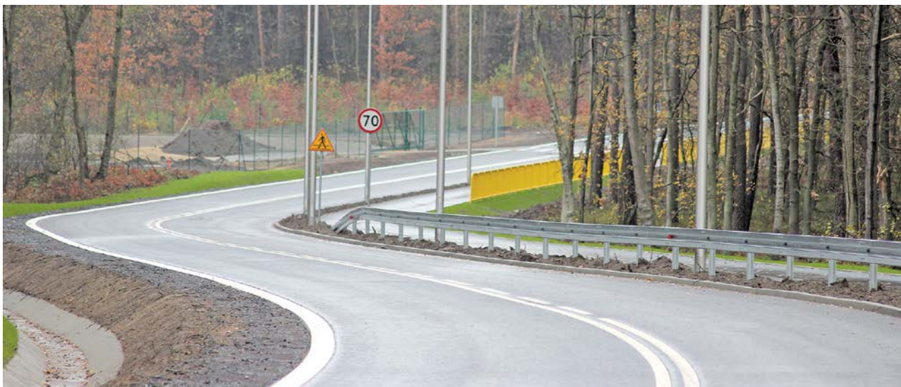
Asfaltowa szosa, o długości ok. 1,7 km, biegnie przez las. Ma drogę rowerową, gęsto poustawiano tu lampy.
