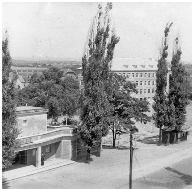
W 1957 r. rozpoczęto budowę szkoły przy ul. Chopina (dziś Gimnazjum nr 6). Na wprost wiatraka działało kino letnie Warszawa.
