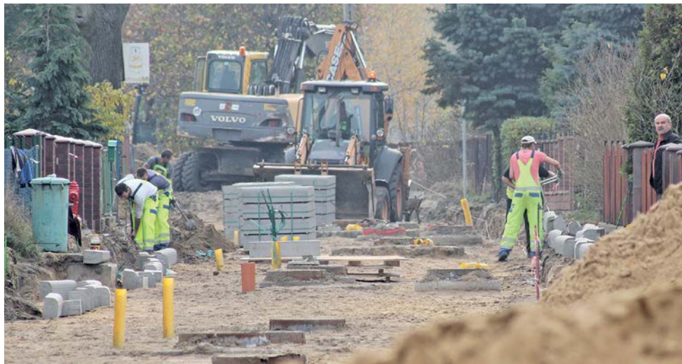
Praca na ulicy Turystycznej wrę. Tak budowlancy uwijali się jeszcze przed Wszystkich Świętych Zdjęcia Krzysztof Grabowski
