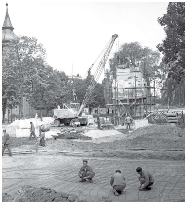
Pomnik trzeba było zmontować na miejscu. Lipiec 1965 r.
