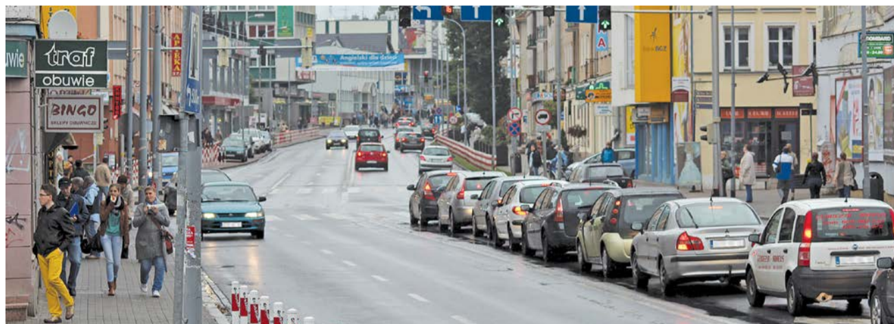
Remont ul. Boh. Westerplatte polegałby głównie na odnowieniu nawierzchni ulicy, która jest w złym stanie Fot. Krzysztof Grabowski
