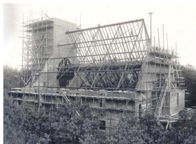
Budowa kościoła pw. Najświętszego Zbawiciela
