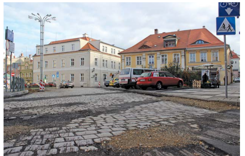
Bruk, odsłonięty podczas prac naprawczych, pozostanie na swoim miejscu
