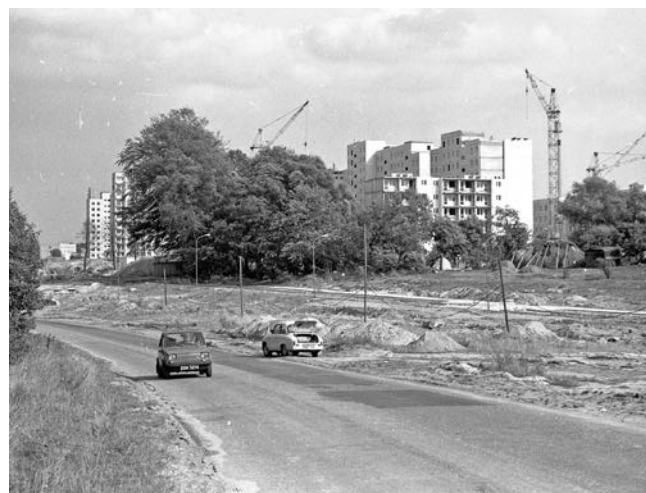
Stara Szosa Kisielińska na wysokości os. Pomorskiego. Widok od strony nieistniejącego wiaduktu
