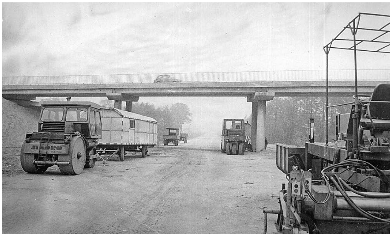
To już obwodnica Zielonej Góry. Budowa jednego z wiaduktów nad S3.
