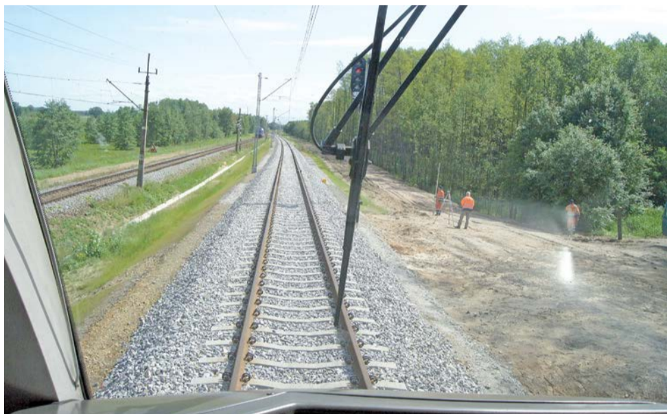
Co zyskają pasażerowie? Czas i komfort. Pociąg pojedzie szybciej po zmodernizowanej i krótszej trasie.
