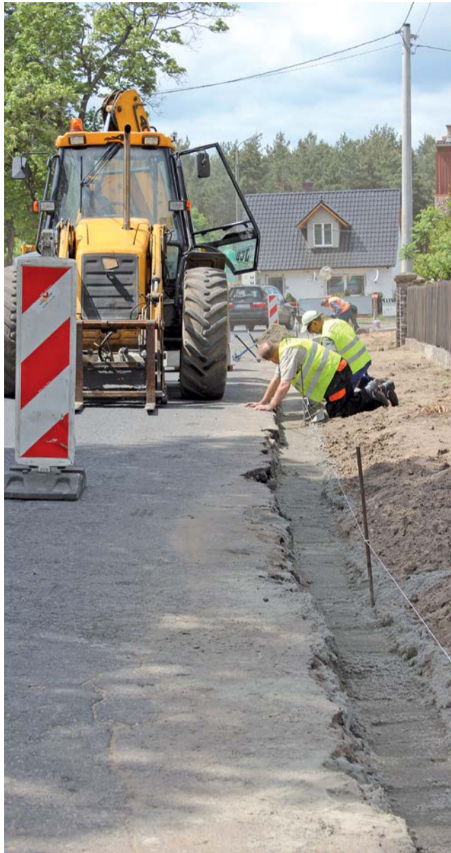
Prace w Janach ostro ruszyły z kopyta. Tuż za przystankiem ulokowała się ekipa budowlana, obok wyrosła hałda grys, po drugiej stronie ulicy trwają pomiary i wykopy.
