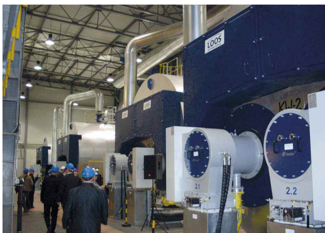
Będzie oszczędnie i ekologicznie. W Elektrociepłowni „Zielona Góra” uroczysto uruchomiono nowy blok kotłów gazowo-olejowych.
