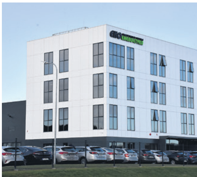
Nowa siedziba Ekoenergetyki w Nowym Kisielinie Fot. Tomasz Czyżniewski
