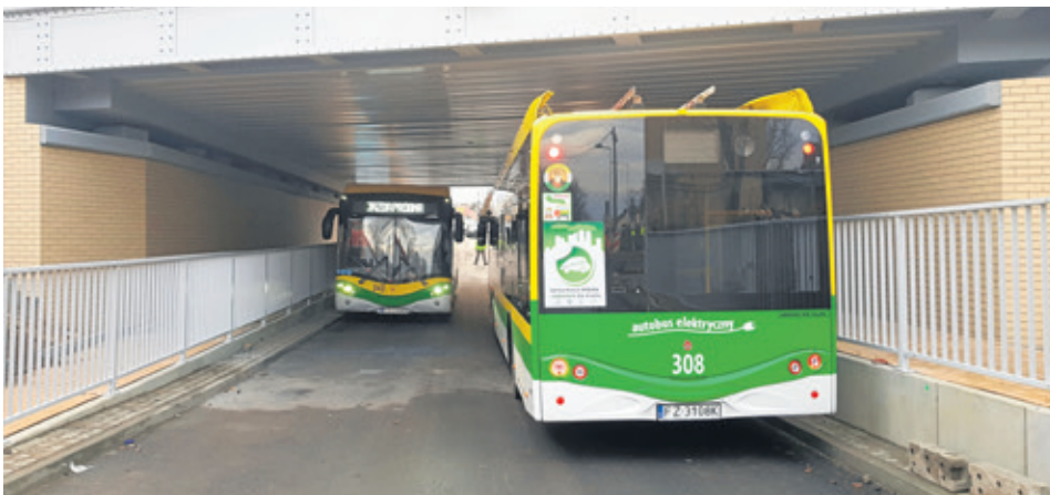
W poniedziałek odbyła się próba generalna - pod poszerzonym wiaduktem bez problemów miną się dwa autobusy Fot. Materiały MZK
