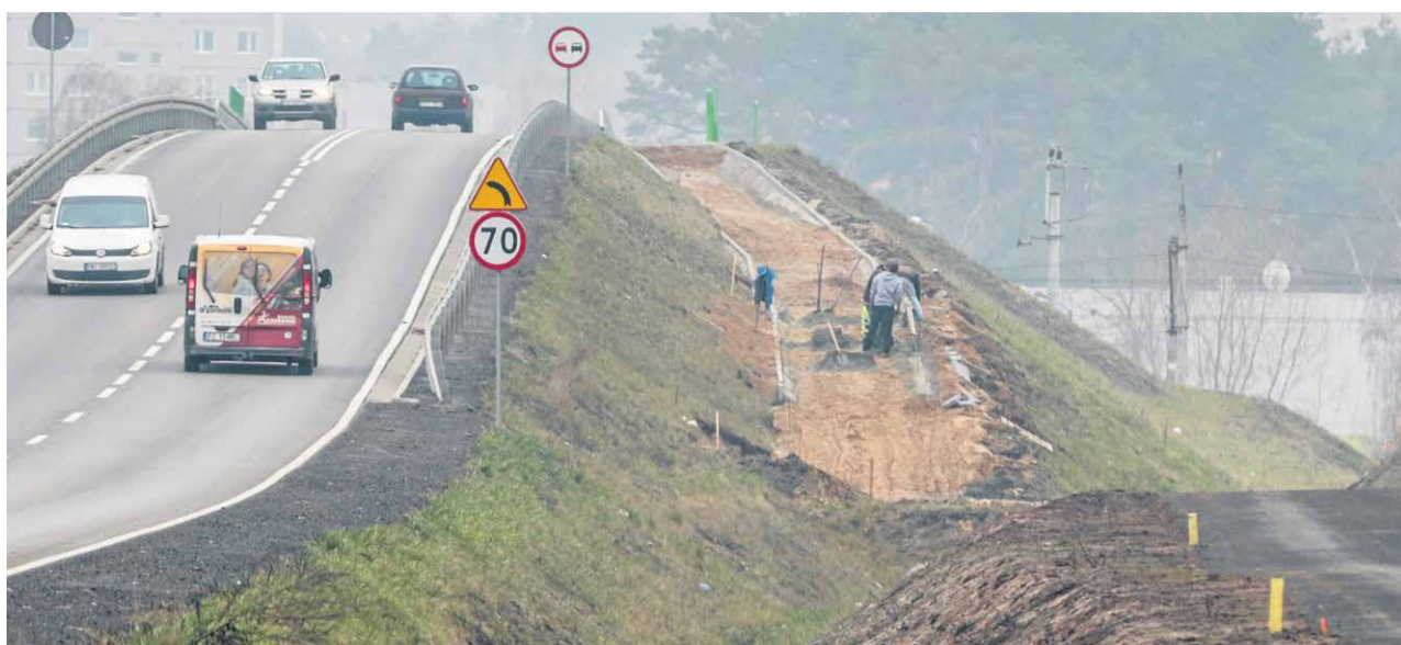
Trwa kształtowanie nasypów pod nową drogą dla rowerów, w kierunku wiaduktu drogowego nad torami kolejowymi
