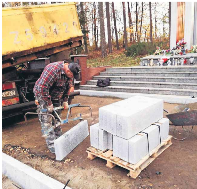
Po obu stronach asfaltowej drogi będą granitowe krawężniki Fot. Rafał Krzywiński
