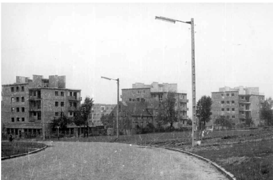
Budowa domów przy ul. Konicza – skrzyżowanie ul. Podgórznej z ul. Waryńskiego. Widok od strony ul. Lwowskiej. Fot. Bronisław Bugiel
