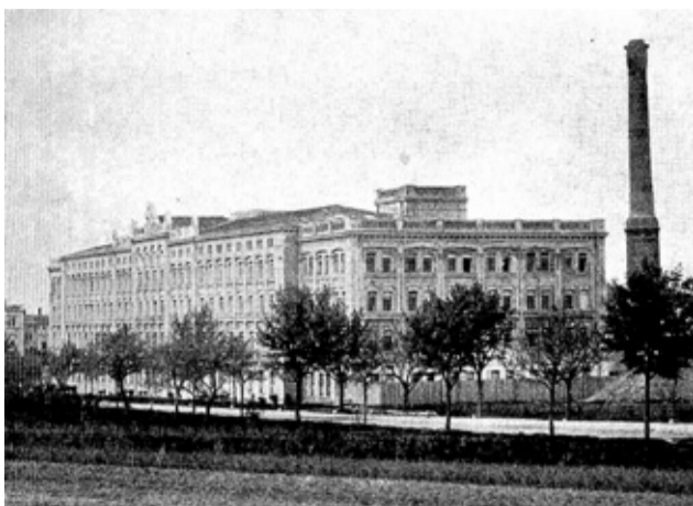
Budynek fabryczny na początku XX wieku
