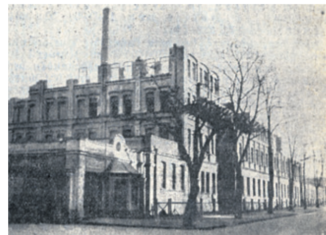
Początek prac rozbiórkowych
