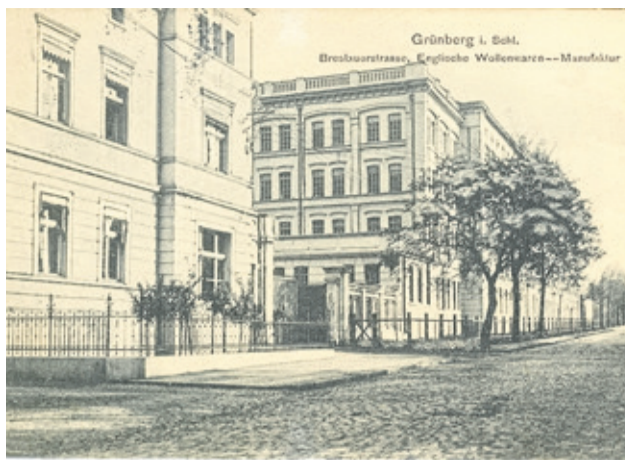
Wjazd na teren fabryki
