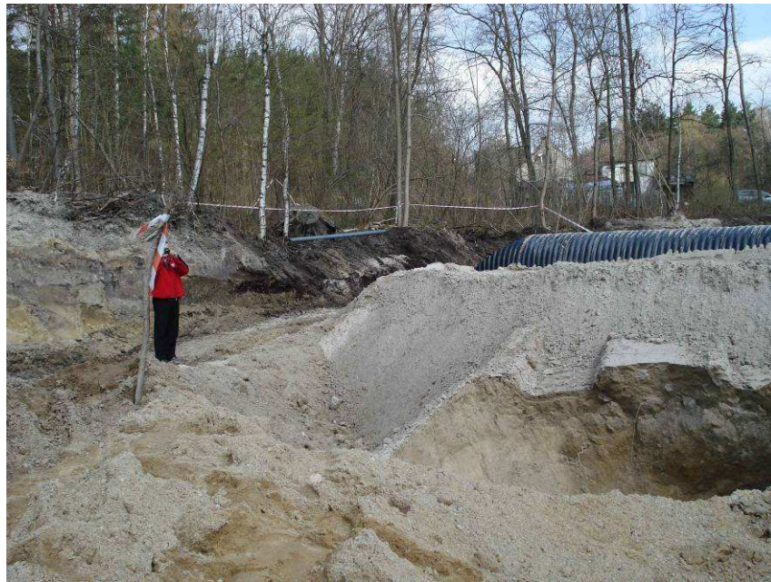
Fot. 5.4. Zapadlisko w miejscu szybu na obwodnicy Łęknicy, 2011
