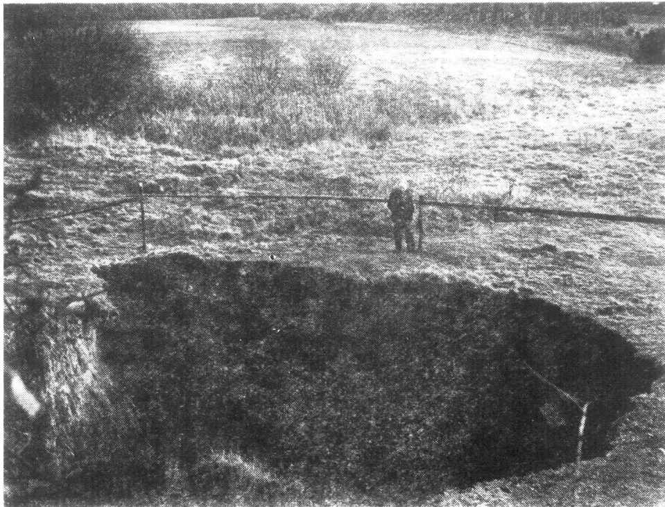
Fot. 5.1. Zapadlisko powstałe w miejscu jednego z szybu Schloin
