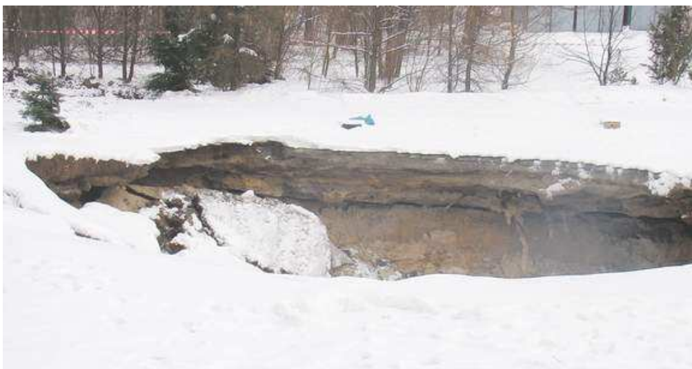
Fot. 5.6. Zapadlisko na terenie przysiółka Rybno. Stan na luty 2012.
