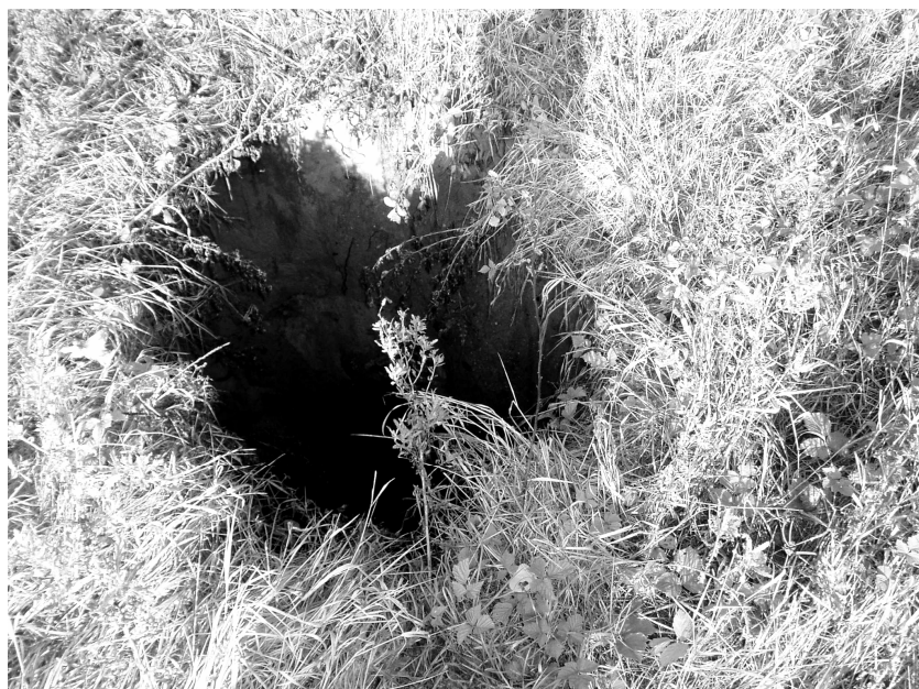
Fot. 5.2. Zapadlisko w miejscu szybu Pohlenz VII, rok 2005, fot. M. Białek
