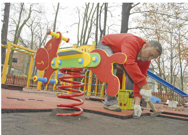
Zjeżdżalnie, bujaczki, już stoją na skwerze przy al. Niepodległości. Niedługo plac zabaw będzie gotowy. W poniedziałek ekipa kładła bezpieczną nawierzchnię. Fot. Krzysztof Grabowski
